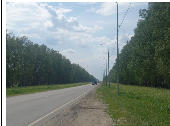
Автодорога «Подъезд к с. Дивеево»
