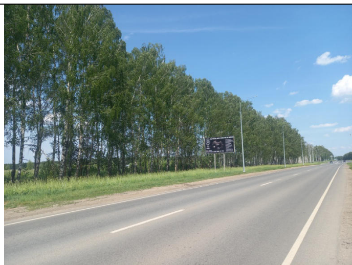
Автодорога «Подъезд к с. Дивеево»
