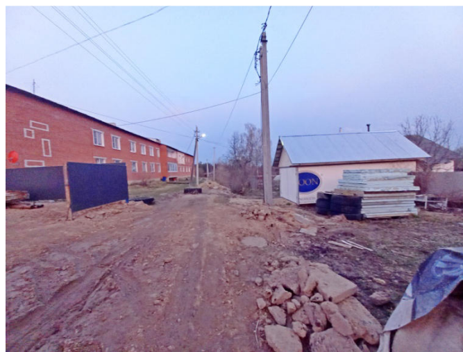
Подъездные пути к оцениваемому дому
