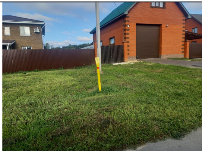
Газопровод по ул.Гаражная
