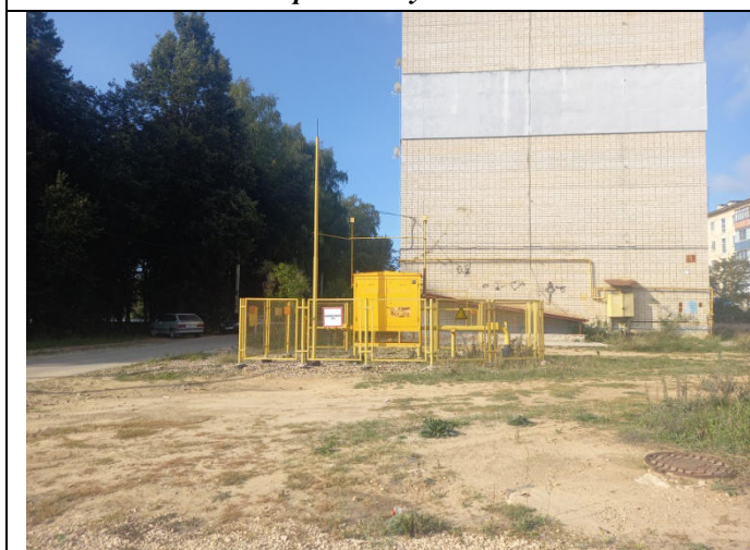
Газопровод по ул.Заводская
