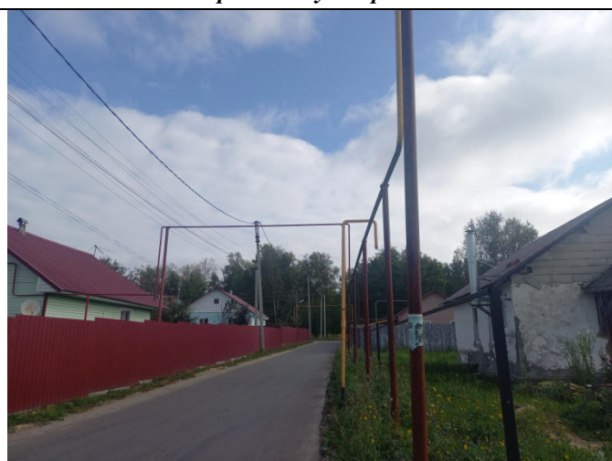
Газопровод по ул.Московская
